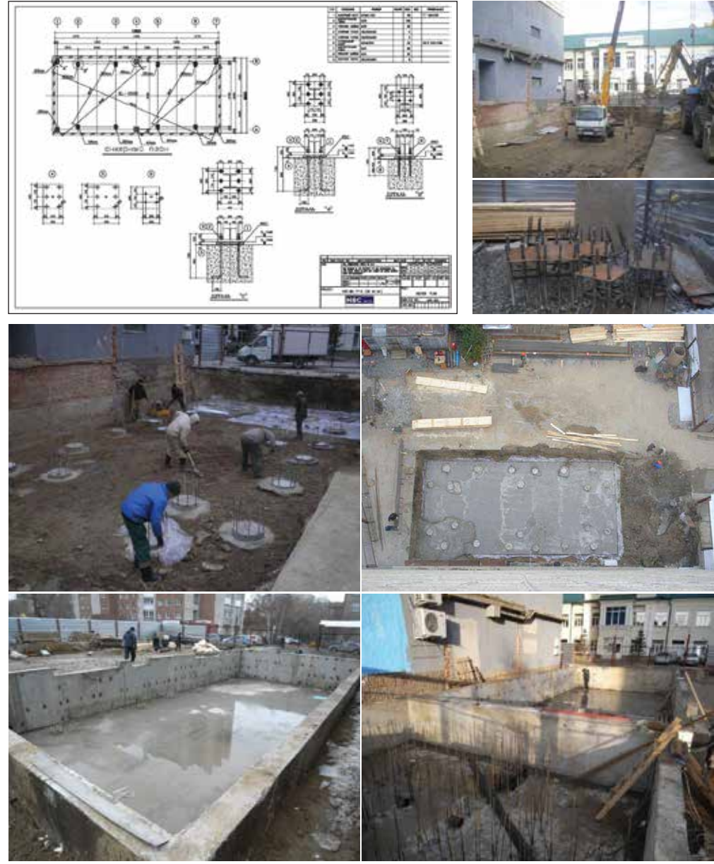
Фундаментные работы на объекте [площадка в России]
