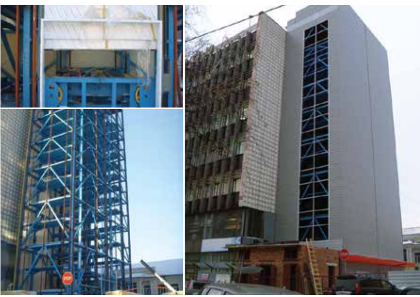
Завоз оборудования на площадку. Установка металлоконструкций, дверей, внешняя отделка.
